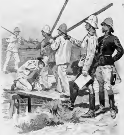
Construction d'un pont sur le Betsiboka.
